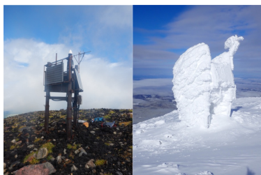
図4. 気象庁の十勝岳探検火口観測点左が夏の状態、右が冬の状態。観測継続には火山ガスや雪水対策が重要（札幌管区気象台提供）
