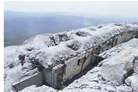
山小屋の屋根をこわした噴石。なんとか噴石を山小屋の屋根が食い止めた。
